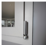
Particolare telaio/anta con vista vetro a filo
