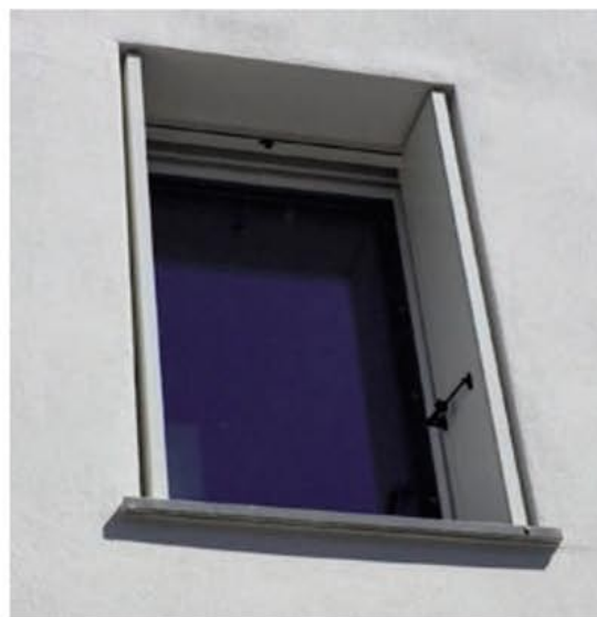
Particolare di PIEGA in apertura
